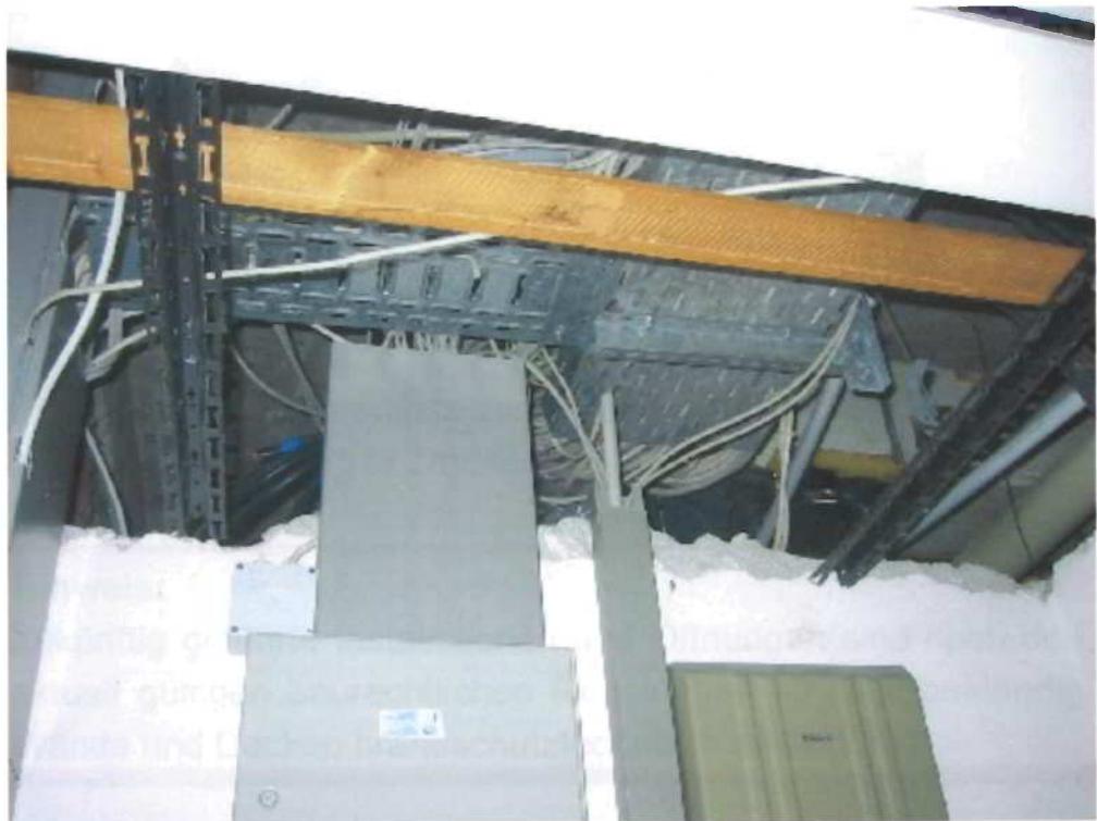
Fehlender oberer Abschluss im Elt-Raum EG, Einbau einer F90-A Decke v. oben u. Unten z.B. in Trockenbau erf.
